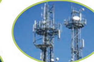
Antennes de télécommunications
